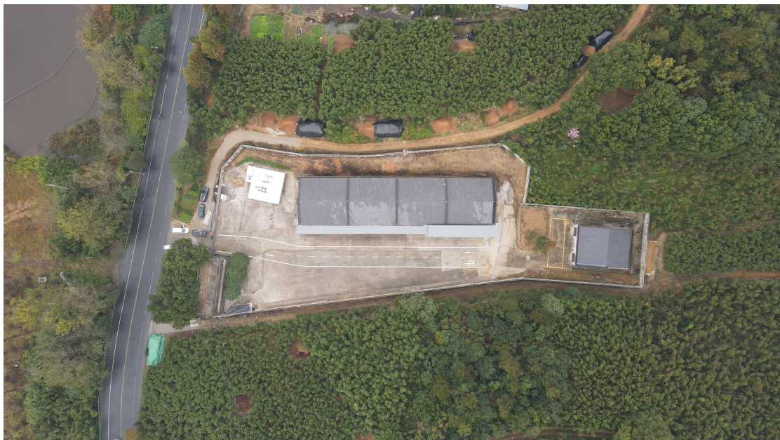
现场勘察时的库区航拍图
