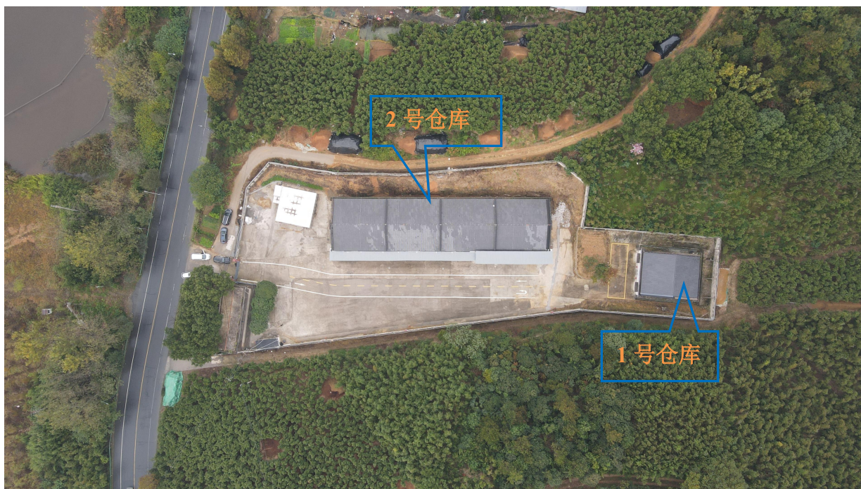
现场勘查时的库房航拍图
