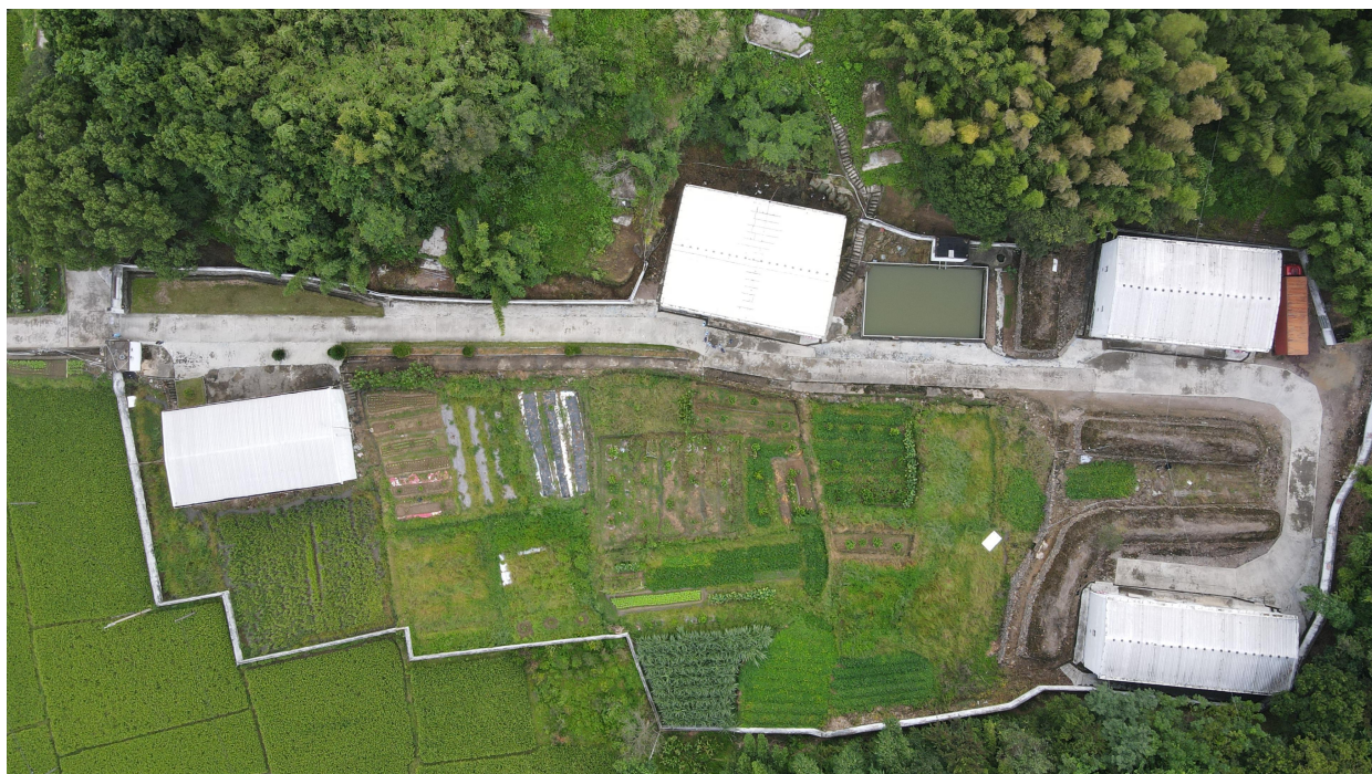
现场勘察时的库区航拍图
