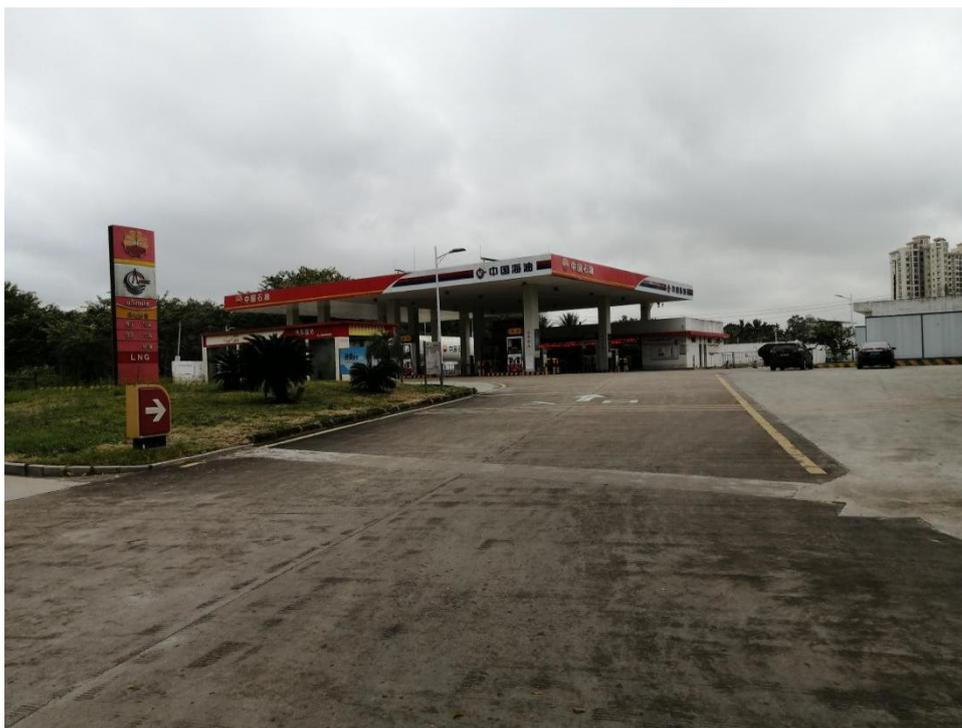
海北路，北面有架空电力线、通信线和民房，南面有架空电力线和民房，东面有架空电力线、民房。该站现有 30m<sup>3</sup>92#汽油储罐 1 个，30m<sup>3</sup>95#汽油储罐 1 个，30m<sup>3</sup>0#柴油储罐 2 个，油罐总容积为 90m<sup>3</sup>（柴油罐容折半计入）；LNG 储罐 60m<sup>3</sup>；依据《汽车加油加气加氢站技术标准》（GB50156-2021）的规定，该站是二级加油加气合建站。其中 LNG 储罐于 2022 年 6 月竣工，目前尚未投入运营。
