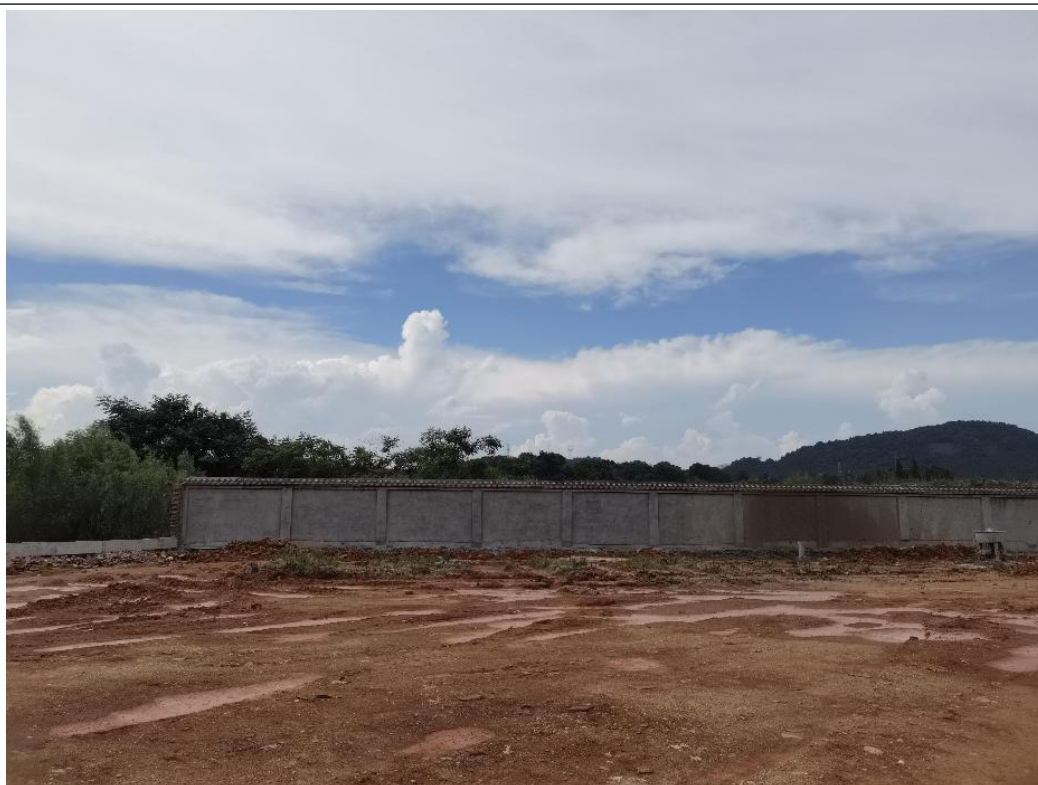
北面：拟建分宜县汽车客运站配电房
