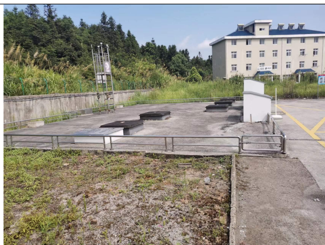
加油站油罐区
