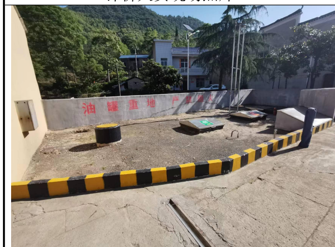
加油站油罐区
