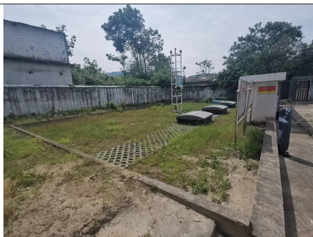
加油站油罐区
