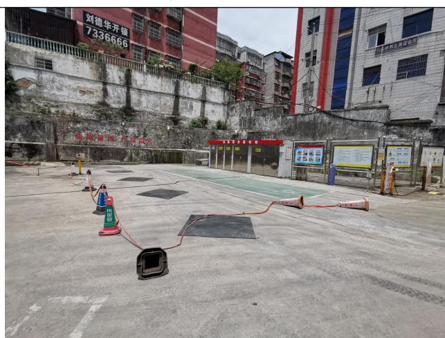
加油站油罐区
