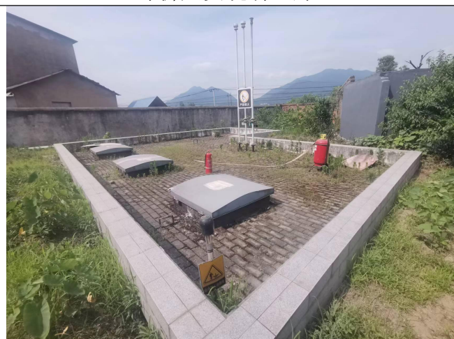
加油站油罐区
