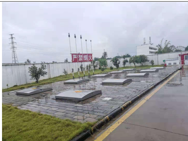
加油站储罐区
