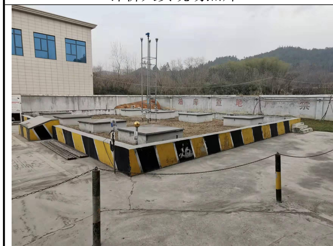
加油站油罐区
